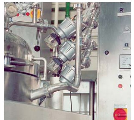
Mediensteuerung in einer Haarfärbemittelproduktion.
