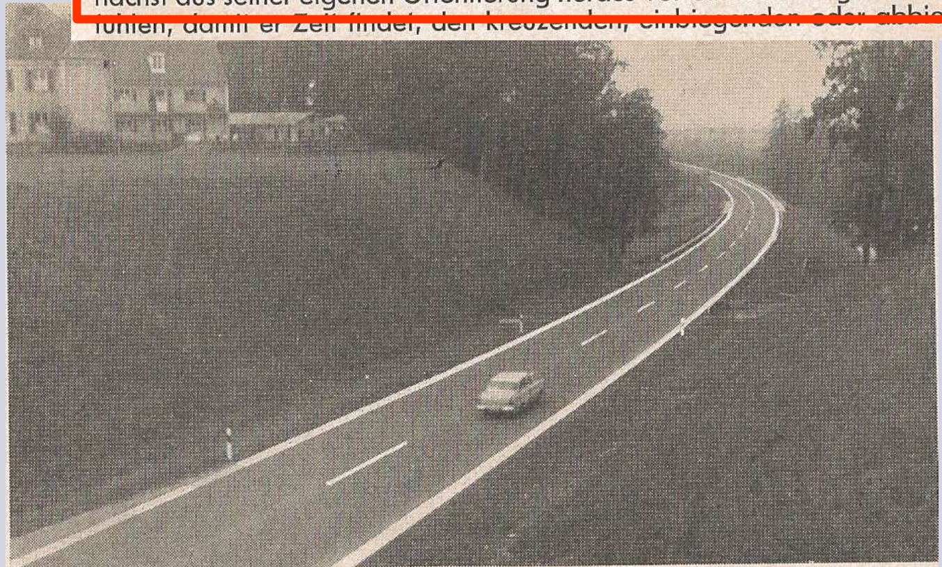
Lehrstuhl Straßenbau Bild 3: Die hellen, reflektierenden Randstreifen zeigen dem Fahrer den Straßenverlauf aus weiter Entfernung deutlich an, so daß er seine Fahrweise darauf einstellen kann.
