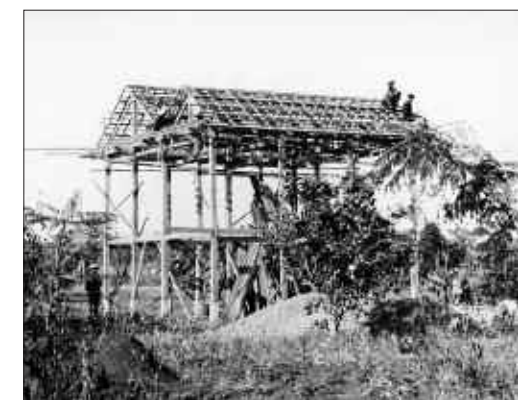
Abb. 7: Nach Fertigstellung des Grundgerüsts werden die Pfosten eines Hauses in Phoum Snay, Provinz Banteay Mean Chey noch einmal justiert.
