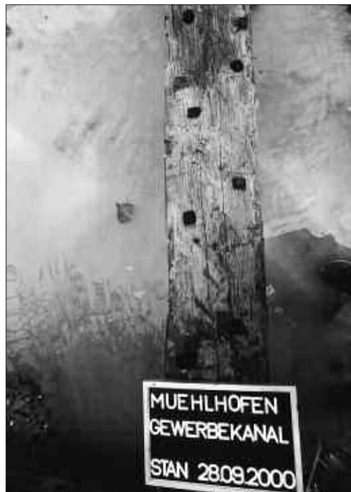
Abb. 8: Detail der Verdübelung des Kanalbodenbelages in Spreizholz 6.
