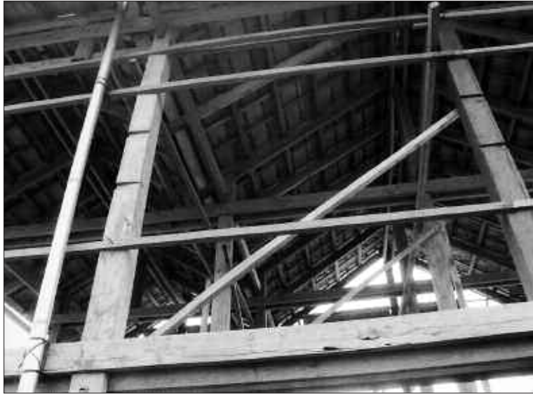
Abb. 9: Detailansicht des Hausgerüsts des 4 x 4 Pfostenhauses in Samrong (vgl. Abb. 8). Im Vordergrund zur Anbringung der Wandbretter das horizontale Lattengerüst, das in Nuten in den Pfosten eingelassen ist.
