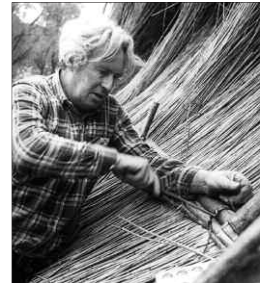
Abb. links: Herr Wohlers beim Dachdecken.
