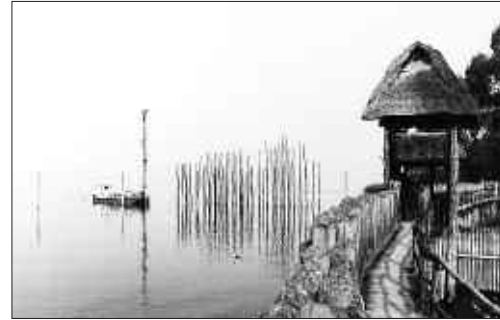
Abb. 20 (oben): Die ersten Pfähle sind gerammt, September 2000.
