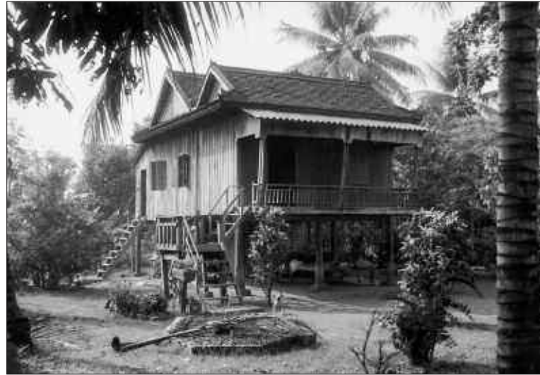
Abb. 1: 3 x 5 Pfostenhaus mit zwei hintereinander gestaffelten Pteah Katang Slab-Dächern in Krek, Provinz Kampong Cham. Die vordere Seitentreppe führt zum Haupteingang auf der Frontveranda, über die kleinere Hintertreppe hat man Zugang zum Küchenanbau. Der hintere Teil des Unterpfeasteraums ist z.T. als Lagerraum umbaut.
