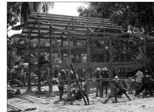
Abb. 6: Detailansicht des 3 x 3 Pfostenhauses bei Krek (vgl. Abb. 3): die waagerechten Gerüstbretter werden durch Fächer in den Pfosten hindurchgeführt und mit Keilen arretiert.
