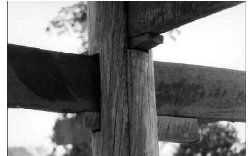
Abb. 6: Detailansicht des 3 x 3 Pfostenhauses bei Krek (vgl. Abb. 3): die waagerechten Gerüstbretter werden durch Fächer in den Pfosten hindurchgeführt und mit Keilen arretiert.
