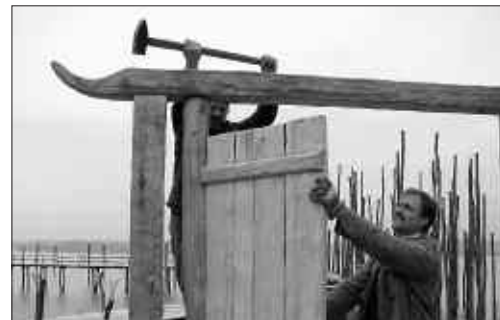
Abb. 22 (oben): Das Handwerkertor entsteht, April 2001.
