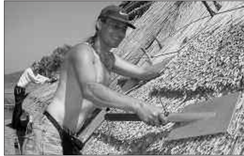
Abb. 30 (oben): Die Dachdeckung beginnt.
