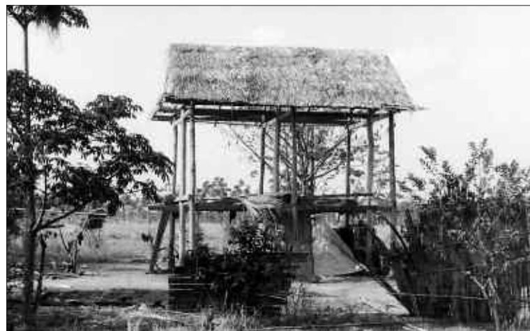
Abb. 3: Einfaches 3 x 3 Pfostenhaus mit Grasdeckung bei Krek im Bau (vgl. Tab.1). Die bauende Familie bewohnt während der Bauzeit einen durch Bretter und Planen geschützten Raum rechts zwischen den Hauspfosten.
