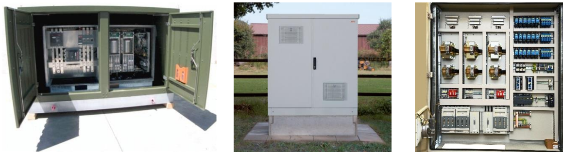
Abbildung 1.3: Bauformen unterschiedlicher Spannungsregler: Links: ABB [6], Mitte: AEG PS [7], Rechts: Walcher
