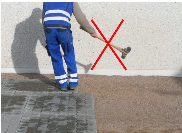
Abb. 7: Maschinell verlegte Steine nur ausrichten, nicht press zusammenreiben
