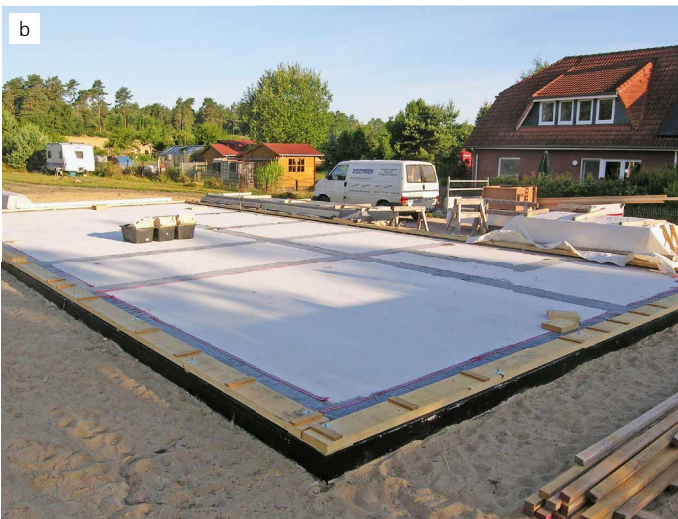
Abb. 2: Rohbau eines Einfamilienhaus in vier Tagen vor Ort erstellt a) Abbund auf der Baustelle b) Schwellen mit Anschlägen für die Stiele montiert c) Montage der Stiele für die Außenwände d) Aussteifende Beplankung der Giebelwände
