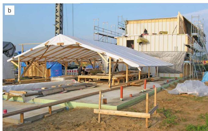
Abb. 1: Zwei Varianten der Baustellenfertigung a) Überschaubar: Einfamilienhaus b) Elementfertigung vor Ort für eine Reihenanlage
