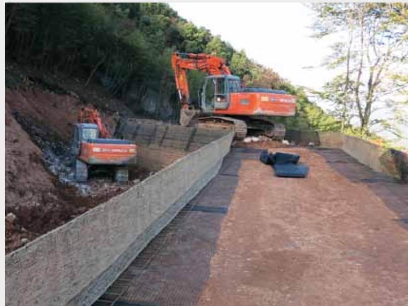
Hangsicherungen, Hangverbauungen, Befestigung von Straßenaufschüttungen, Erdbeben gefährdete Abhänge, Steinschlagdämme und Lawenschutzdämme sind nur einige der zahlreichen Anwendungsbereiche für das System der "Bewehrten bzw. Armierter Erde".
