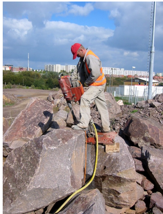
Abbildung 14: Entnahme von Syenit-Bohrproben mit Betonkernbohrgerät aus Haufwerksblöcken eines Sprengvortriebs.
