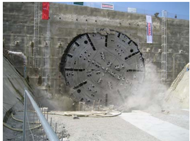
Abbildung 1: Durchschlag einer Hartgesteins-Tunnelbohrmaschine (TBM): Der Ermittlung zutreffender ingenieurgeologischer Kennwerte für Planung und Ausführung anspruchsvoller Felsbauwerke kommt nicht nur bei großen Infrastrukturprojekten mehr denn je eine entscheidende Bedeutung zu.
