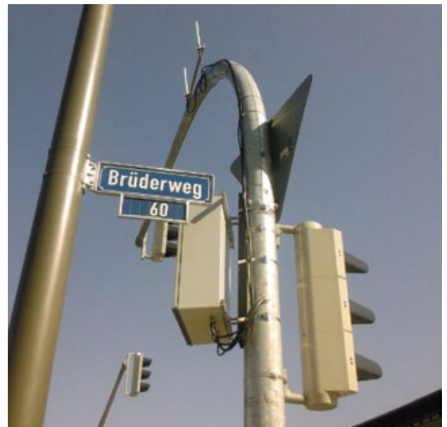
Interoperabilität: Eine Fahrzeugeinheit aus Spanien sollte mit diesem RSU in Deutschland kommunizieren können. Quelle: PTV
