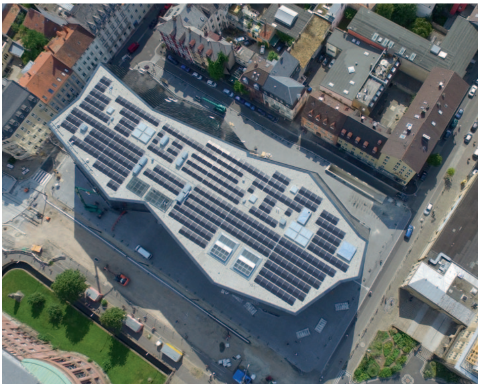
Die Universitätsbibliothek versorgt sich zum Teil selbst mit Strom – auf dem Dach befindet sich Freiburgs größte innerstädtische Fotovoltaik-Anlage.
