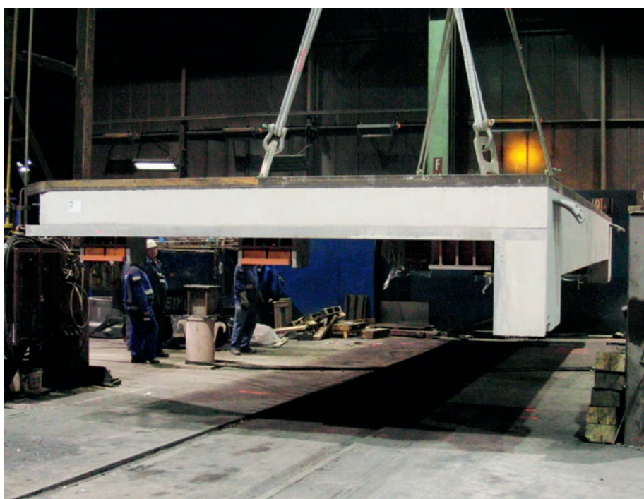
Anlieferung einer Deckelhälfte
