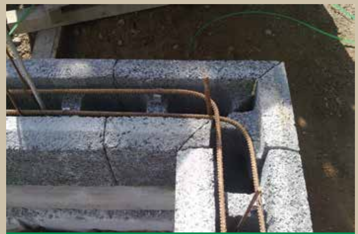
4.1. Montarea armăturii la colțuri
