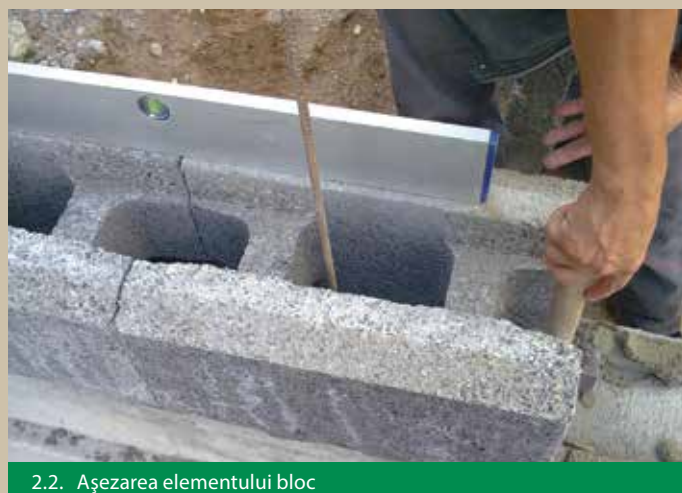
2.1. Așezarea elementului bloc
