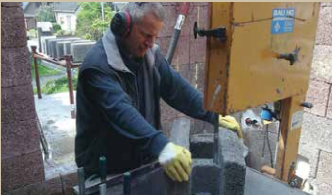
3.1. Tăierea elementului de colț
