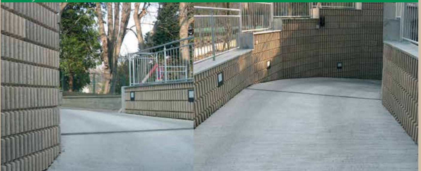
Montaj ulterior pe zid de beton (LSA)
