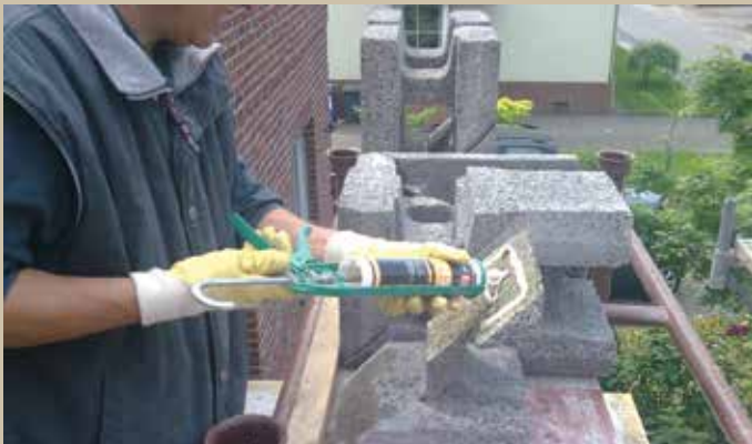
3.2. Fixarea elementului de colț cu spumă adezivă universală Leier FIX
