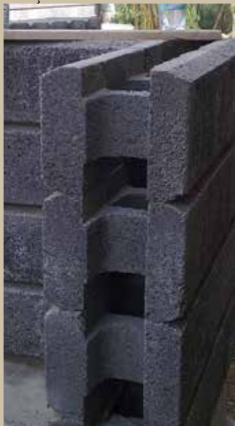
4.4. Capăt de zid înainte de cofrare
