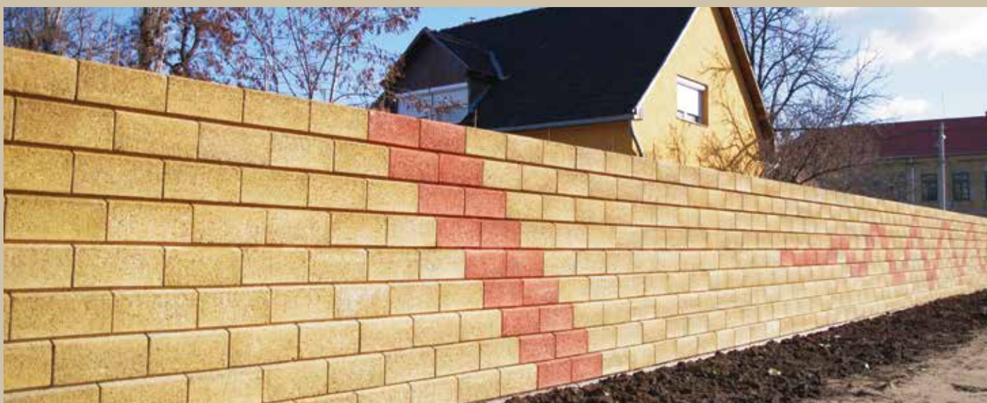
Sistemul de perete pentru atenuarea zgomotului, finalizat
