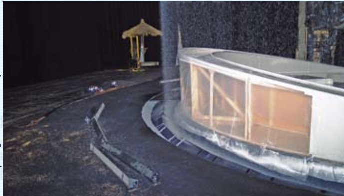
Das Wasser wird in einer Rinne aufgefangen. Deutlich zu erkennen die das Rauschen mindernden Kunststoffwinkel in der Rinne.
