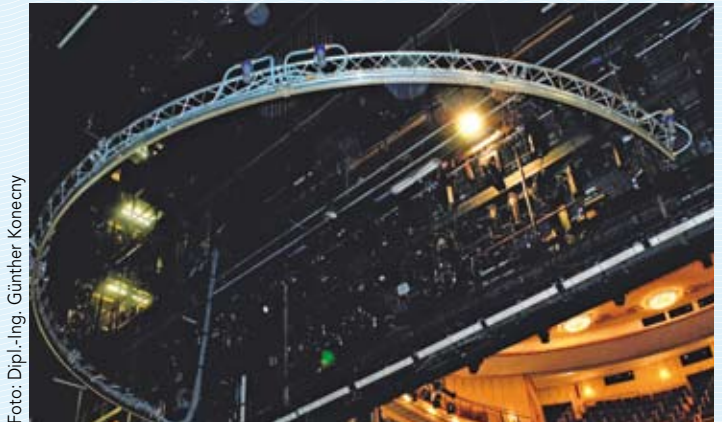
Die Position des Düsenrohrs im Bühnenbereich
