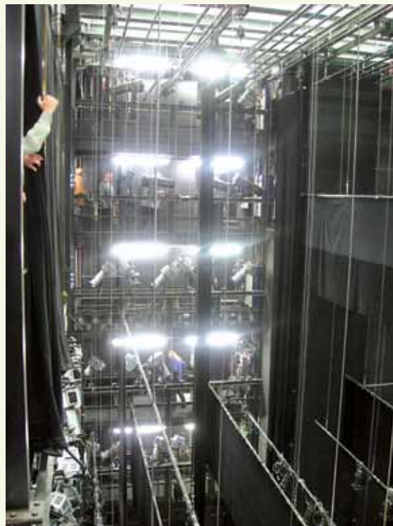
Der Bühnenturm der großen Bühne des Schauspielhauses nach der Generalsanierung
