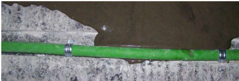
Detail „Fließverhalten Baustoff“ (Datum: 15.12.2010)
