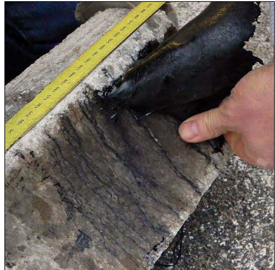
Das Abdichtbitumen lies sich nachträglich händisch abziehen und offenbarte das mit Bitumen penetrierte Rissnetzwerk im Steinsalz.
