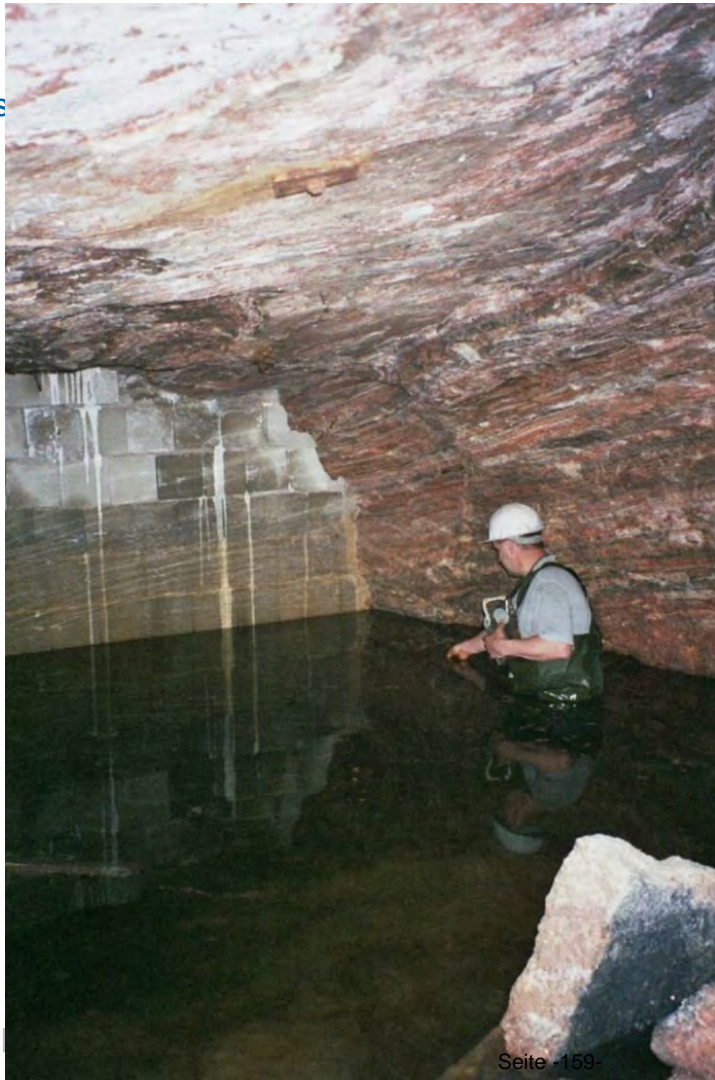
MgO-Damm im Carnallit, Bischoferode, Lösungszutrittsseite
