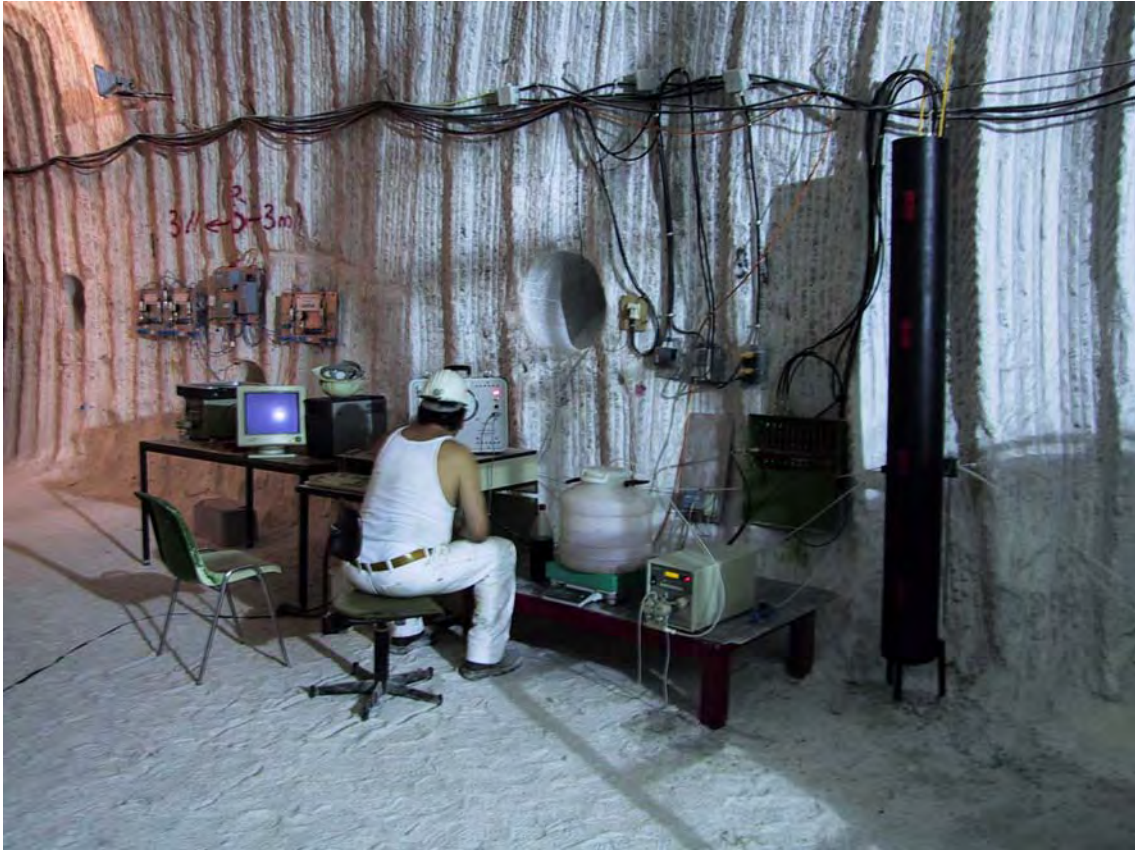
Abb. 47 In situ-Versuch mit „Selbst Verheilendem Versatz (SVV)“ in der Schachtanlage Asse in Bohrlöchern von 15 m Länge und 50 cm Durchmesser
