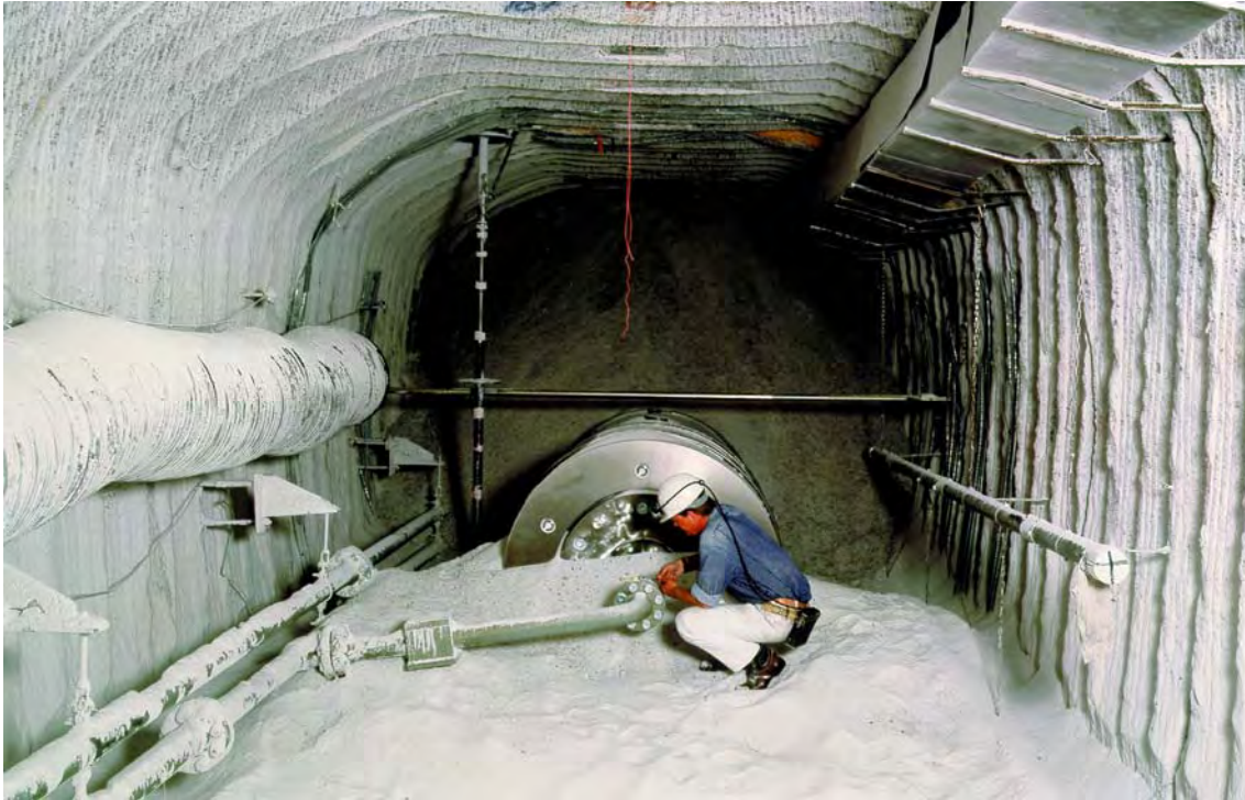
Abb. 42 TSS-Versuchsfeld: teilversetzte Versuchsstrecke mit Behälteratrappe und installierter Messinstrumentierung (Quelle: DBE)
