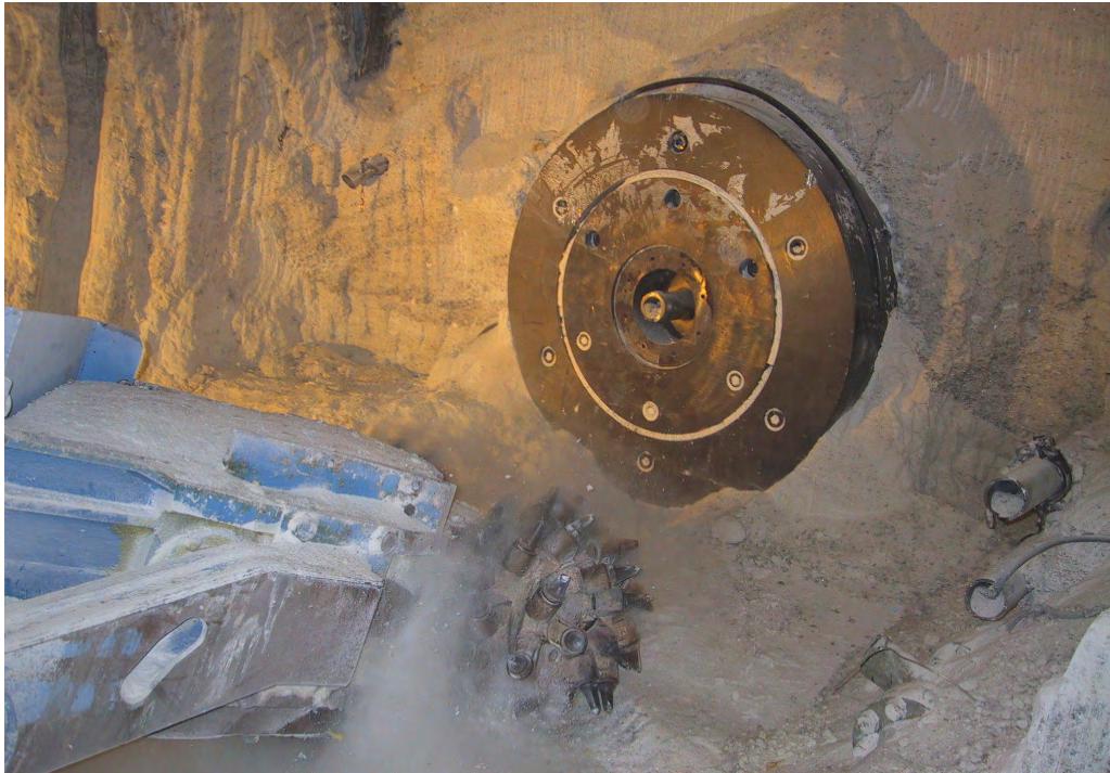
Abb. 43 TSS-Versuchsfeld: Wiederauffahrung einer Versuchsstrecke
