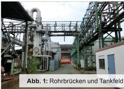
Abb. 1: Rohrbrücken und Tankfeld
