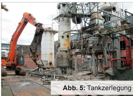
Abb. 5: Tankzerlegung
