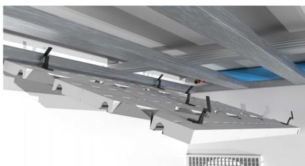
Die Module werden leicht geneigt an das erste CD-Profil angelegt und nach oben gedrückt.
