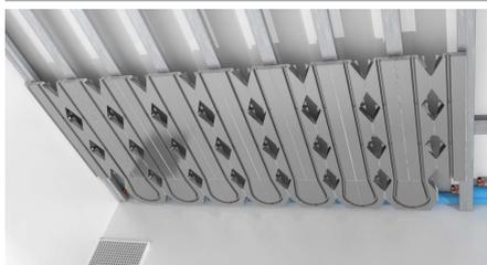
Die Auslegung der Module beginnt in einer Ecke des Raumes, optimal an der Außenwand. Zuerst wird die erste Reihe Umlenker verlegt.
