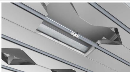
Je nach Anforderung ist es sogar möglich ein 1/16 Stück aus zuschneiden. Dies wird z.B. beim Setzen des Feuchtfühlers notwendig oder wenn ein Pressverbinder benötigt wird.
