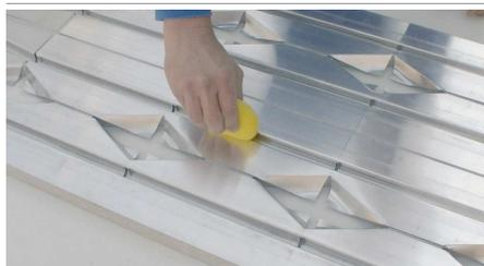
Vor dem Anbringen der Module müssen diese mittels Gleitmittel vorbereitet werden. Dabei wird der mitgelieferte Schwamm mit dem Gleitmittel besprüht und durch die Rohrrillen gezogen. **ACHTUNG:** In den Bögen darf das Gleitmittel nicht aufgetragen werden, da sonst das Rohr nicht hält.
