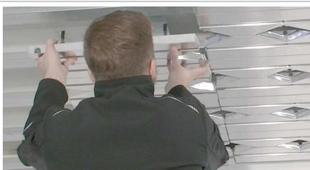
Die zugeschnittenen Module werden in die entsprechenden Freiräume eingesetzt.
