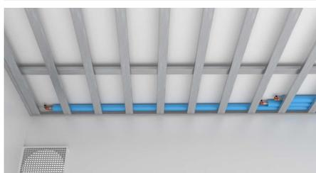
Der Planung wird die Lage der Anschlüsse für die jeweiligen Heizkreise entnommen und die Pressreduzierungen auf das Rohr aufgesteckt.
