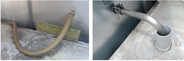
Abb. 1: Die Entnahmeleitungen aus Kunststoff wurden durch rostfreien Stahl ersetzt.
