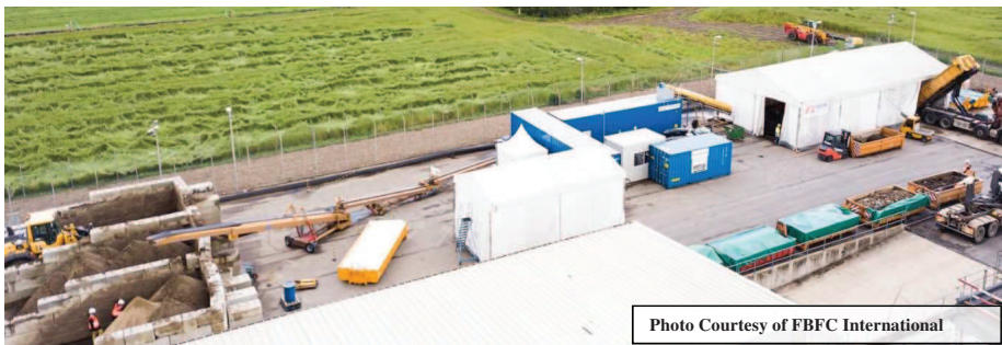
Abb. 4: Überblick über die Bodencharakterisierung und -sortierung mit FREMES: Das Material wird per LKW eingefüllt (rechts), dann gepuffert und über Förderbänder zu den Mess-/Sortierbändern (blaue Behälter) transportiert und anschließend zu Haufen und Behältern sortiert (links)
