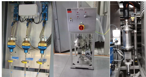
Abb. 2: Aerosolfilterhalterungen Typ RADēCO (links) wurden ersetzt durch Aerosolfiltereinheit Typ AJS-21-V2KV und Jodbilanzierungssammlern Typ AJS-5 von der Firma VerAn.
