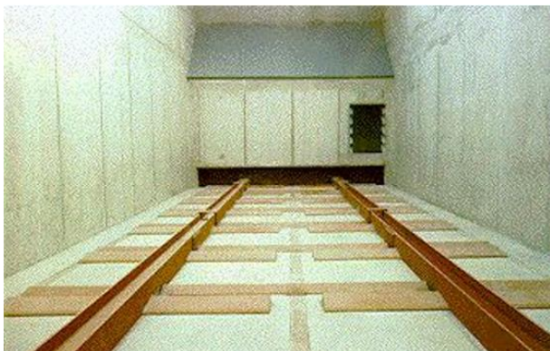
Bild 6.21 Siloaustragung durch Schubboden (Quelle: Schmid energy solutions).
