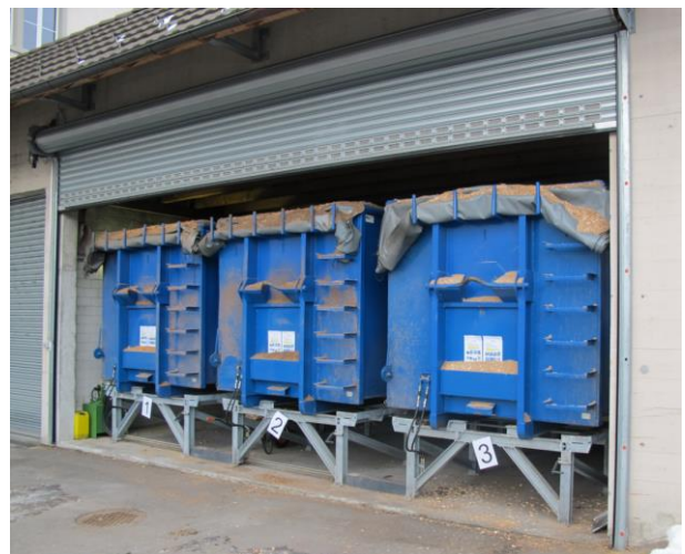
Bild 6.2 Mobile Hackschnitzelcontainer mit Austragung als Siloersatz (Quelle: Holzenergie Schweiz).
