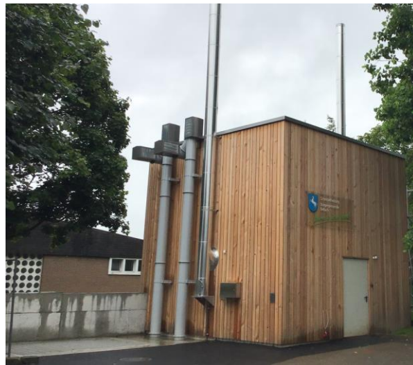
Bild 13.32 Containeranlage mit integriertem Brennstoffsilosystem und einfacher Holzverkleidung (Quelle: Holzenergie Schweiz)
