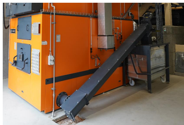
Bild 6.39 Feuerraumentaschungsschnecke (Quelle: Schmid energy solutions).
