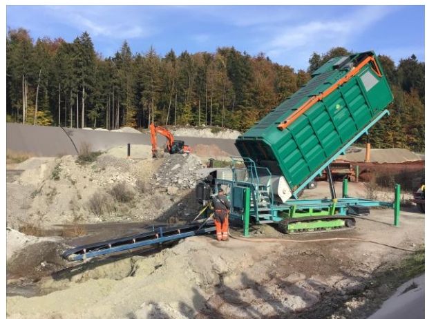
Bild 9.2 Staubfreier Einbau der Holzaschen auf der Deponie (Quelle: Amstutz Holzenergie AG/Holzenergie Schweiz).
