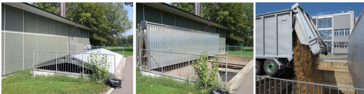
Bild 6.10 Nicht befahrbarer Faldeckel (links geschlossen, Mitte geöffnet, rechts Befüllung. Quelle: Patrik Küttel).
