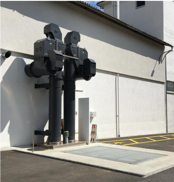
Bild 6.13 Vertikales Schneckenförderersystem (Quelle: Schmid energy solutions).
