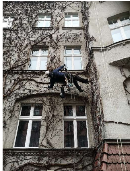
Abbildung 20: Dank des Kletterers ist die Efeu-Reinigung ohne den Aufbau eines Gerüsts möglich
