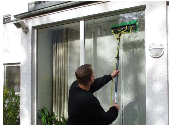
Abbildung 13: Fensterreinigung mit Reinwasser
