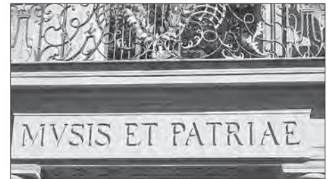
Die Inschrift prangt auf einer Fassade, die ursprünglich an einem andern Ort stand. Wir suchen den Namen ihres Erbauers, eines berühmten Architekten. Sein Name mahnt uns irgendwie an Schoggi und Confiserie. Wie heisst er? Foto: ar
