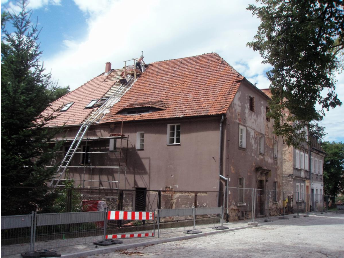
Das alte Pfarrhaus in Renovierung, Juli 2012
