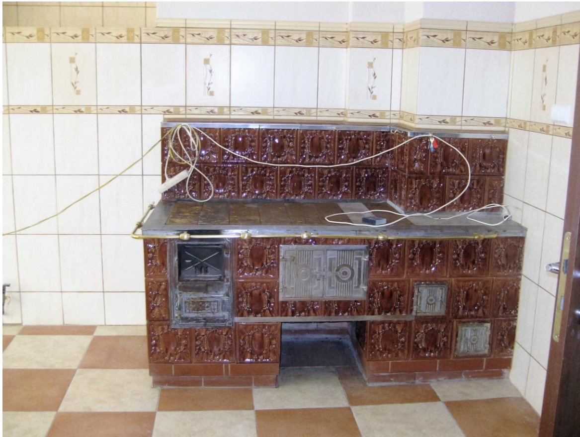
Der Küchenherd im alten Pfarrhaus bei der Renovierung, Juli 2013
