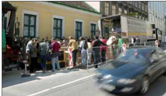
Die Baustelle Barawitzkagasse – durch die grabenlose Leitungssanierung bleiben Straßen weiterhin befahrbar und der Verkehr fließt.
