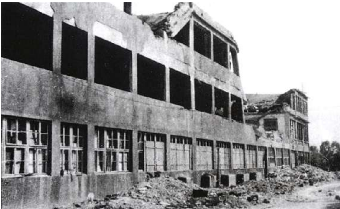
Bombenschäden am Werk II, Wagenseilgasse 2
