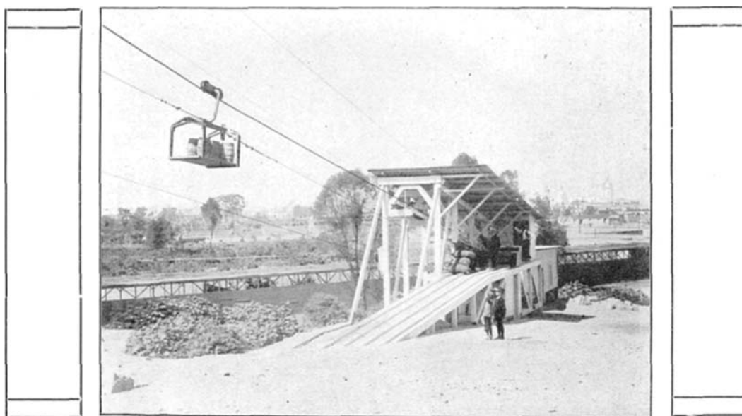
Abb. 117. Transportbahn für den Bau der San Christóbal-Station bei Lima.
