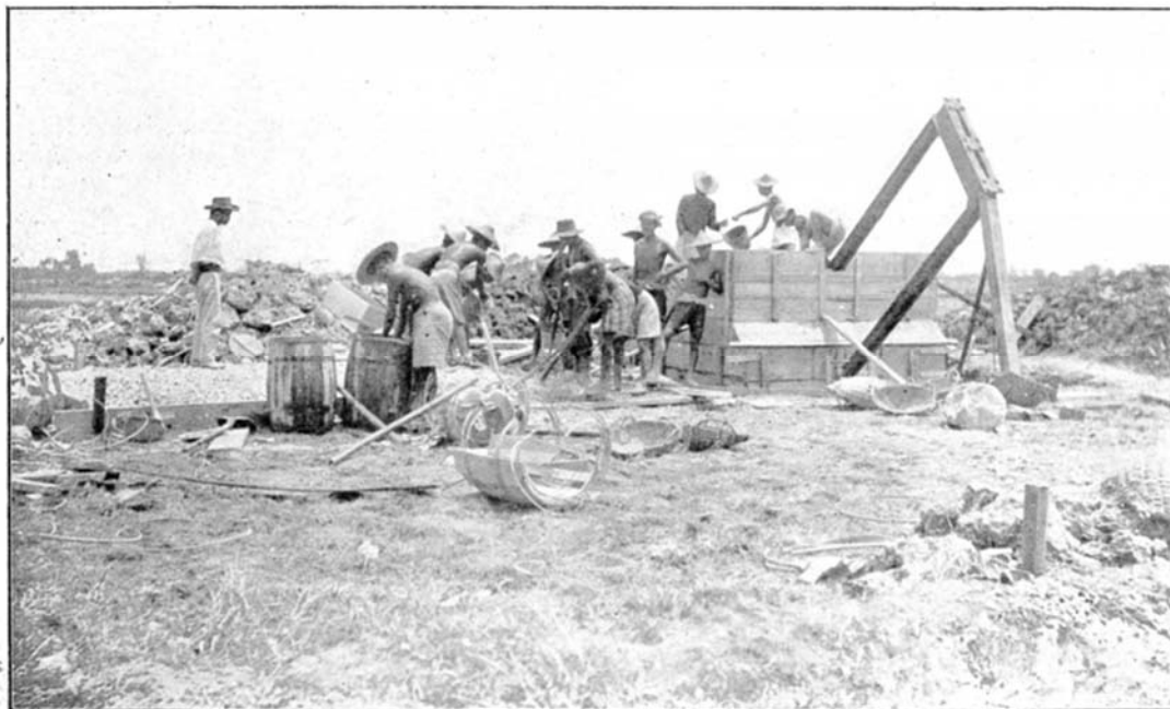
Abb. 138. Bau der Turmfundamente der Telefunkenstation Bangkok.
