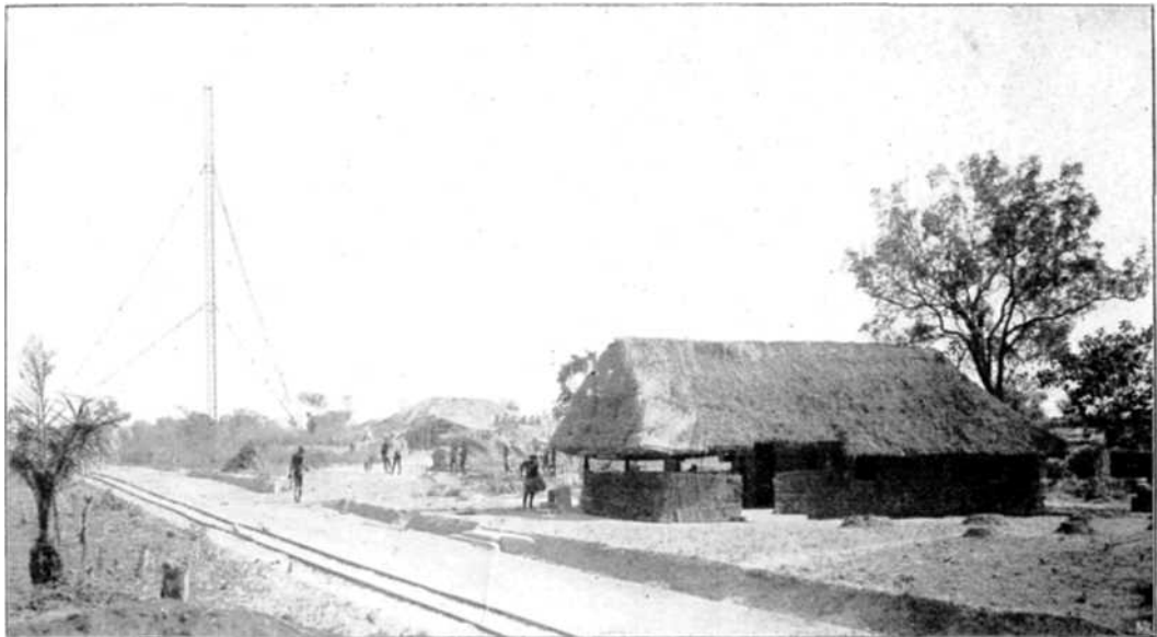
Abb. 129. Bau der Telefunkenstation Kamina (Togo), Fremdenhaus.
