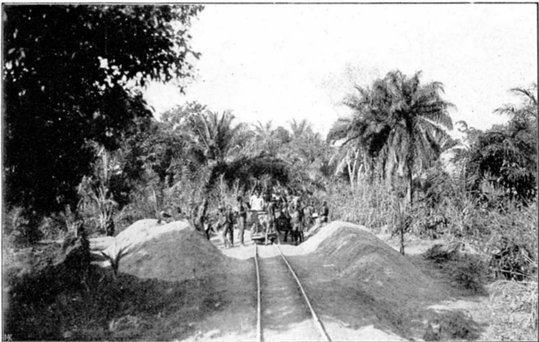
Abb. 125. Bau der Telefunkenstation Kamina (Togo). Sandgewinnungsstelle.
