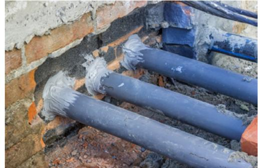
Abb. 15: Abgedichtete Rohrleitungen
