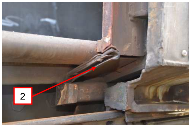
Bild 42: Dichtschlauch am Portal
