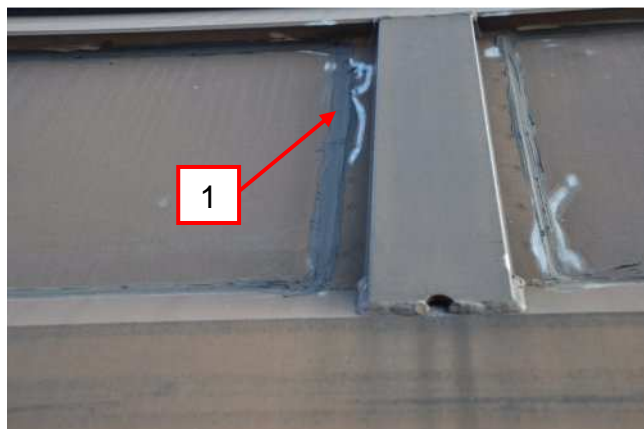
Bild 23: Abdichtung Schiebewand außen
