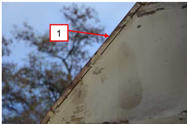
Bild 40: Dichtleiste an Stirnwand
