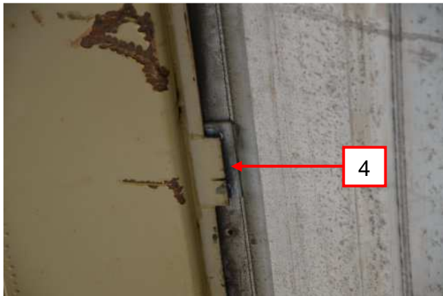
Bild 57: Wandauflage am Dachträger
