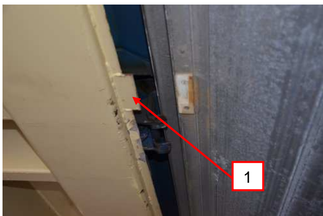
Bild 17: Auflage der Schiebewand am Dachträger
