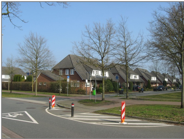
Südliche Blickrichtung Bgm.-Kaisen-Allee; Beginn Borgfeld-Ost und Ecke Kiebitzbrink
