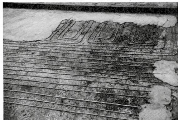
BILD 3. Fußboden-Speicherheizung mit Kabelverlegung auf Zementestrich.
