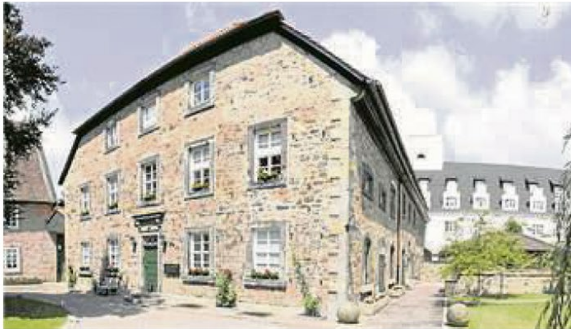
Der Garten und eines der beiden Häuser des Redenhofs sind in den letzten Jahren umfangreich saniert worden. FOTO: DANA
