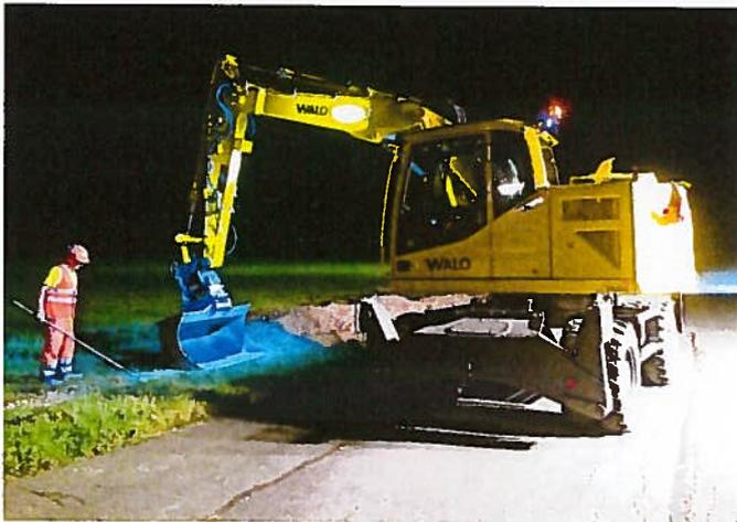
Grabenauffüllung nach der Verlegung der Kabelschutzrohre für die neue Pistenbefehrerung entlang der Piste
