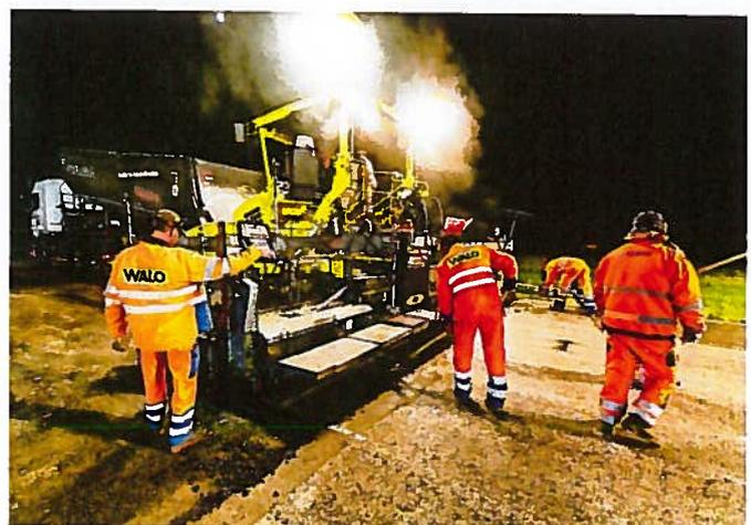
Einbau der Tragschicht auf einer Breite von 7,50 m
