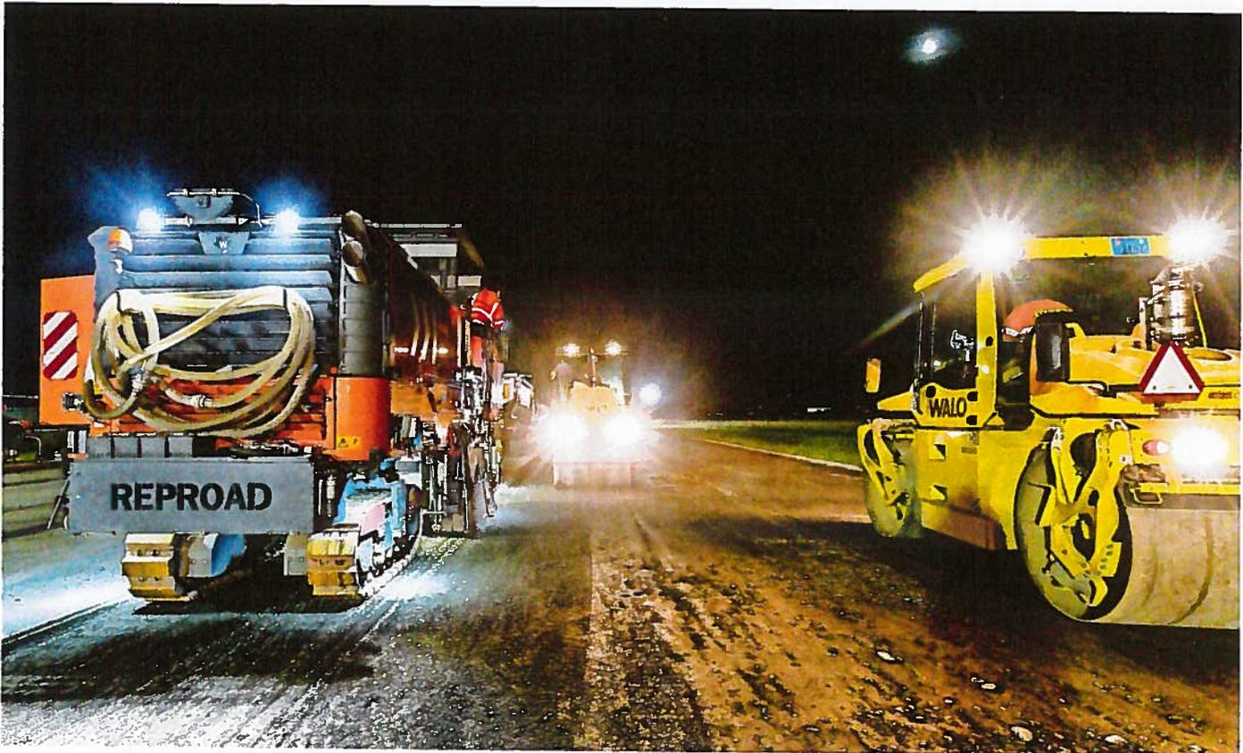
Abbruch des bestehenden Pistenbelages mit zwei Grossfräsen und gleichzeitige Nachverdichtung der Planie
