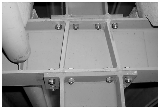
Abb. 1.11: Durchlaufender Unterzug und gestossene Stütze mit Stirnplattenverbindung
