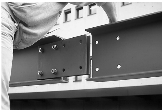
Abb. 1.01: Geschraubter Montagestoss als Gerbergelenk einer Pfette
