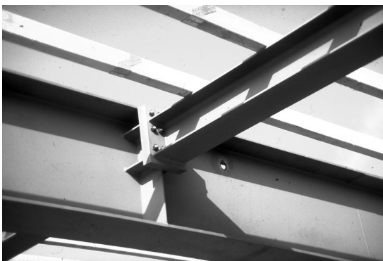
Abb. 1.10: Eingesattelte Durchlaufpfette mittels Stirnplattenstoss beim Auflager verbunden
