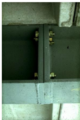
Abb. 1.05: Trägerstoss: Verbindung zweier Einzelteile zu einem Ganzen, Ausbildung als geschraubter Stirnplattenstoss mit bündiger Stirnplatte
