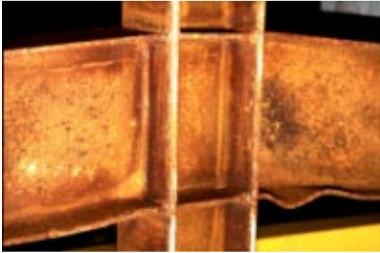
Abb. 4.02: Erreichen des Tragwiderstandes der Verbindungszone durch die Ausbildung des plastischen Moments im angeschlossenen Profil. Im Bild erkennbar durch das dem Fließen im Druckflansch nachfolgende Ausbeulen desselben
