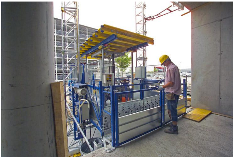
Bild 47: Umsetzen mit Tischhubsystem - Umsetzwagen fährt mit [7]
