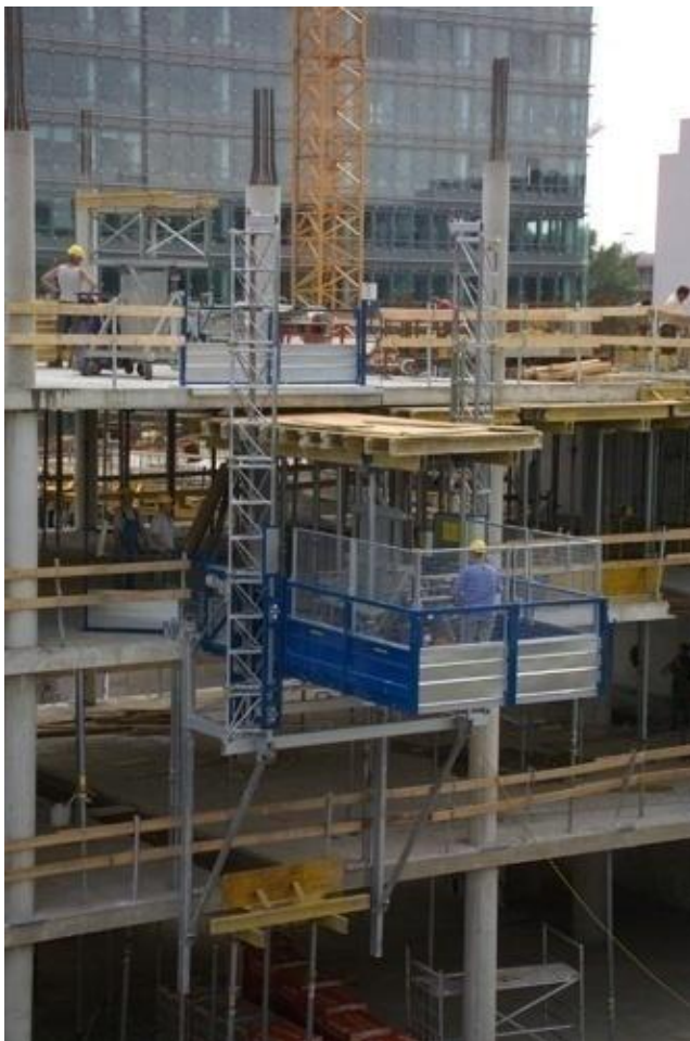
Bild 45: Tischhubsystem (TLS) [6]
