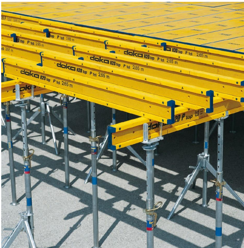
Bild 6: Beispiel für Systemträgerschalung [1]
