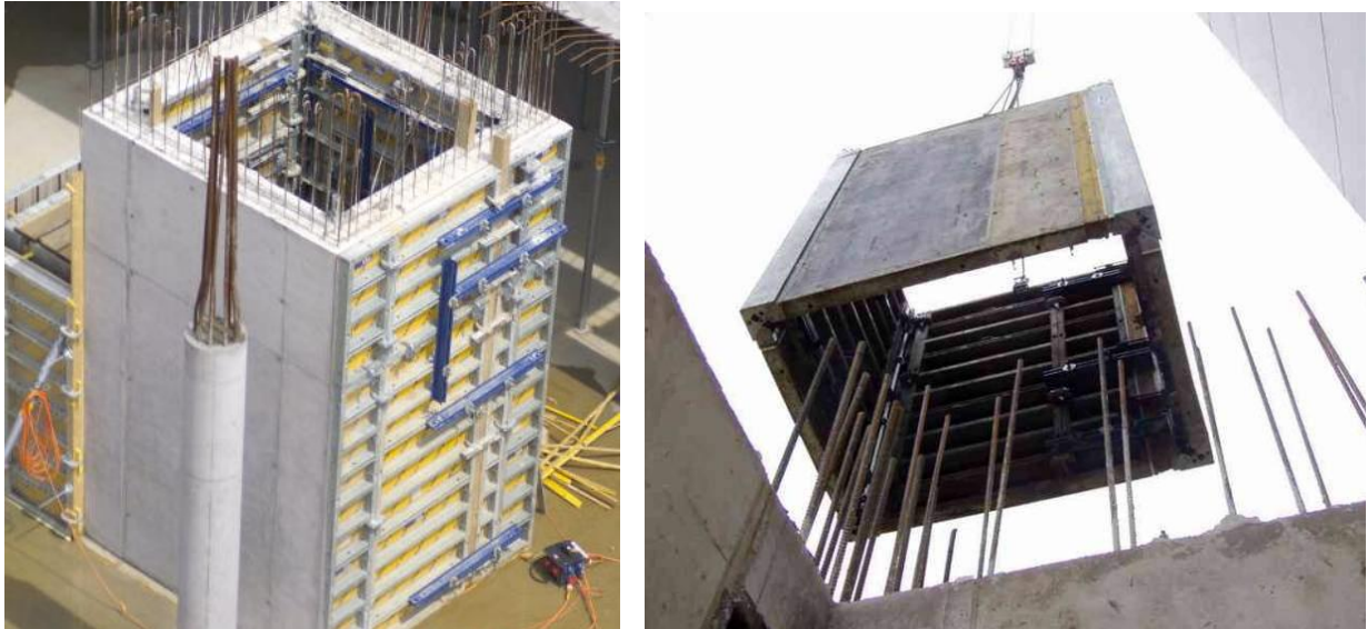
Bild 52: Umsetzvorgang einer Schachtschalung mit dem Kran [3]
