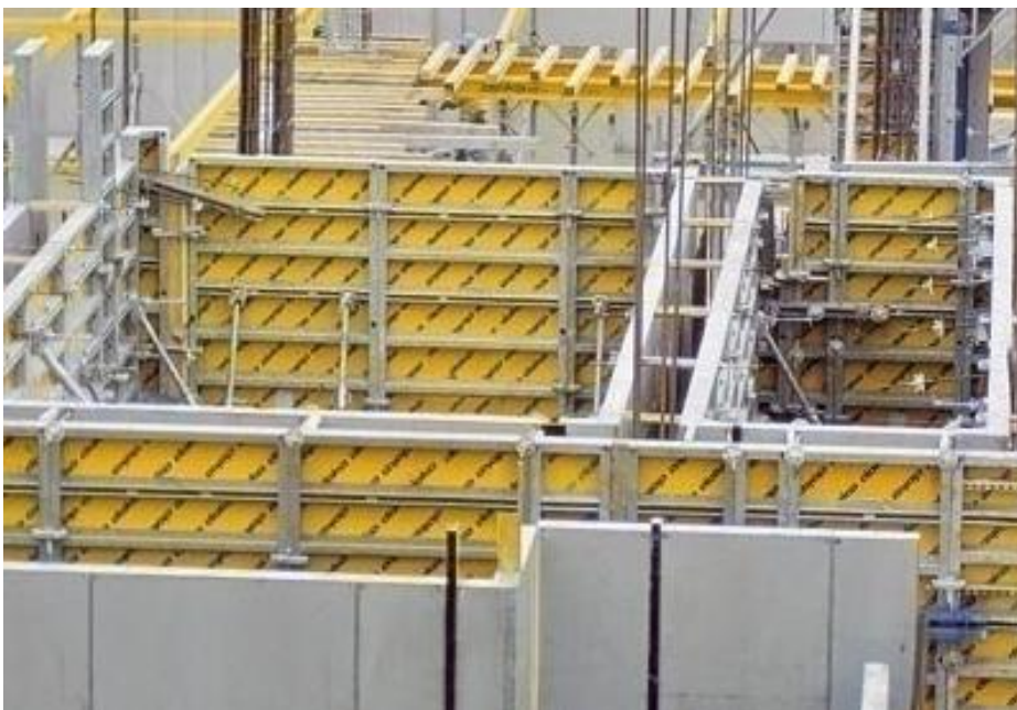
Bild 53: Montierte Rahmenschalung [4]
