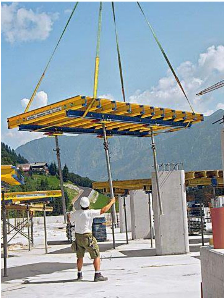
Bild 28: Deckentisch mit Längsträgern aus Stahl [10]
