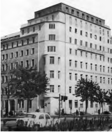
Die Hauptstelle der LZVA in der Mommsengasse, Ecke Wiedner Gürtel (vis-à-vis vom ehemaligen Südbahnhof).
