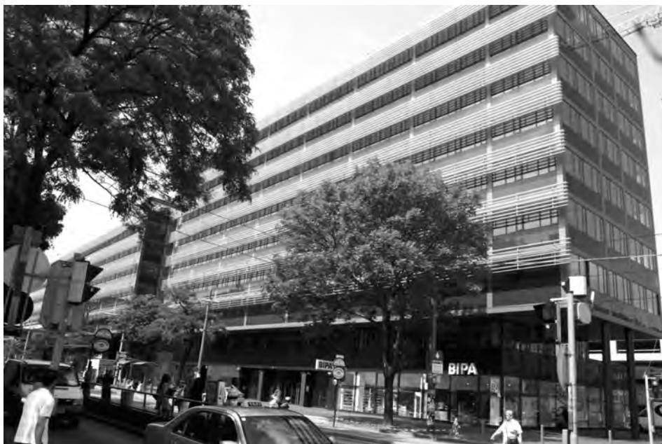
Das Gebäude der SVD in der Dresdner Straße im Juni 2007.
