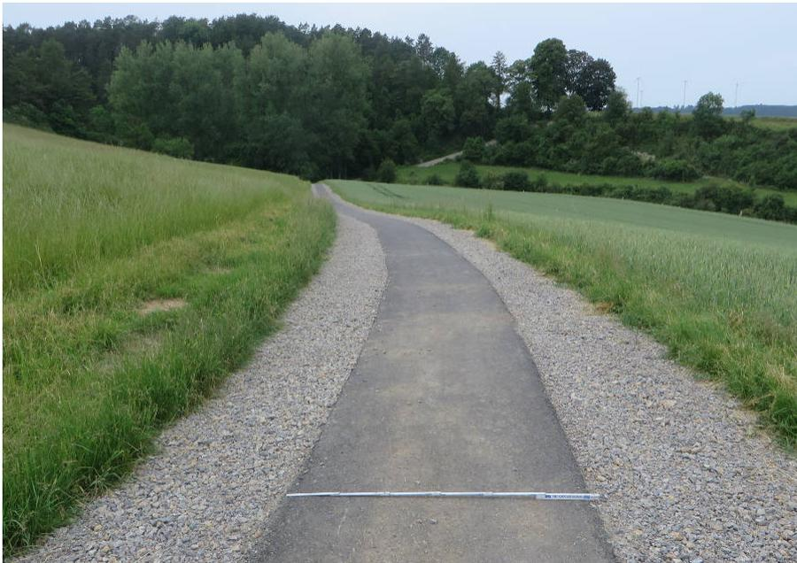
**Abbildung 3.2** Als Lückenschluss wurde der Schotterweg mit einer 1,2 m breiten Asphaltfahrbahn versehen: es besteht die Gefahr offener Bankette und bei Gegenverkehr des RV muss ein Verkehrsteilnehmer in den Schotter ausweichen. Sturzgefahr durch evtl. offene Bankette (LIE\_17).
