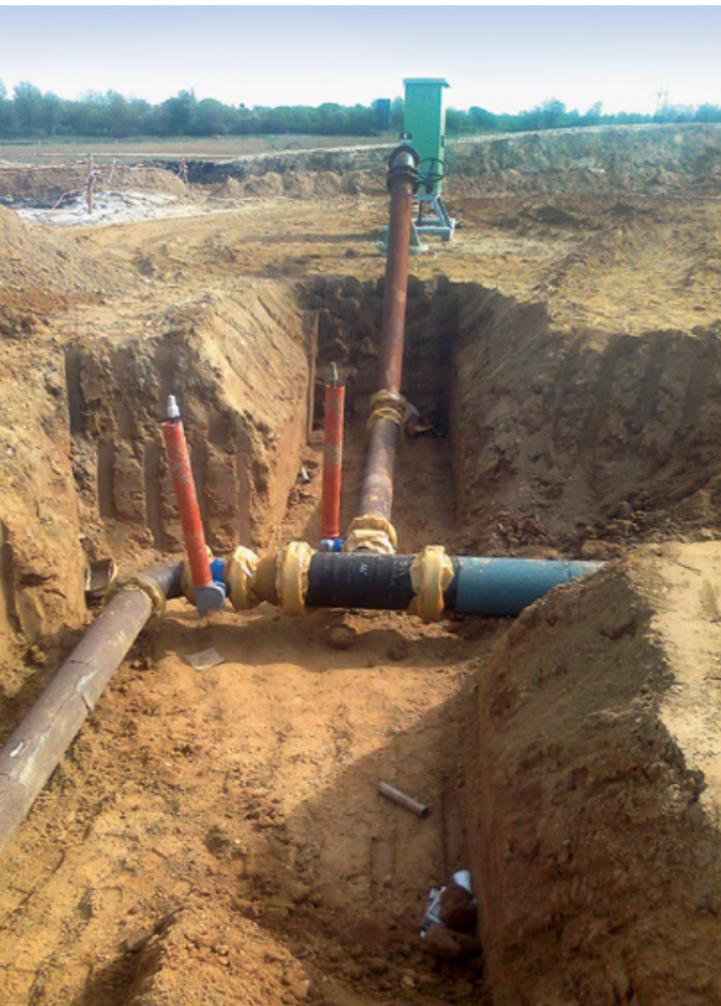
Anbindung eines neuen Brunnens an das Rohrnetz
