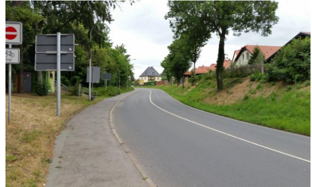
Abb. 9: Rudolstädter Straße: Einschnitt nördlich Claudiusstraße (Blickrichtung Norden)
