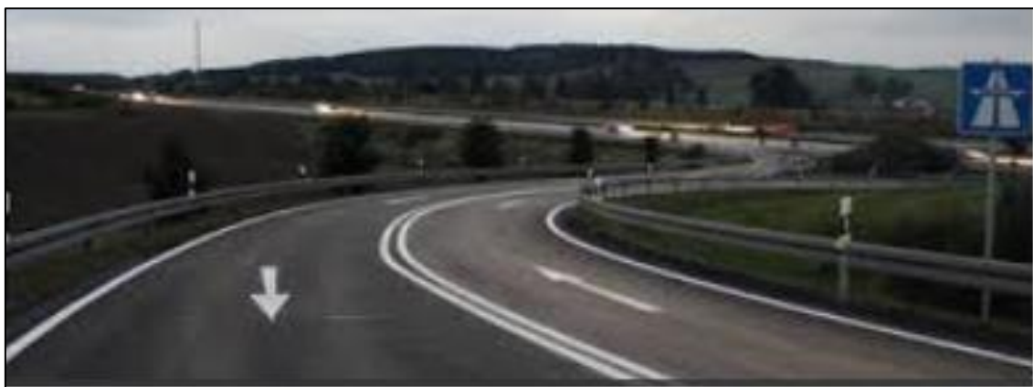
Abbildung 3: Zusätzliche Richtungspfeile gemäß „Schweizer Modell“ in den Rampenfahrstreifen Quelle: Landesbetrieb für Straßenbau
