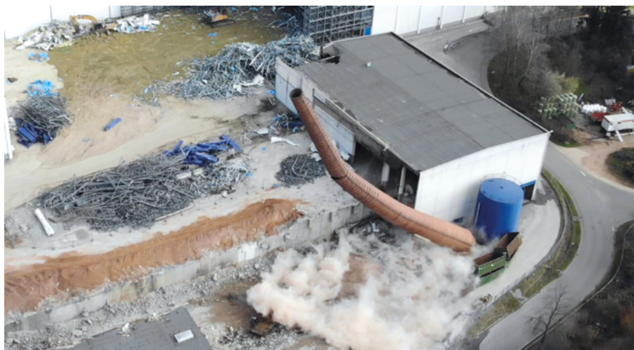
Abbildung 18: Kamin unmittelbar nach der Sprengung
