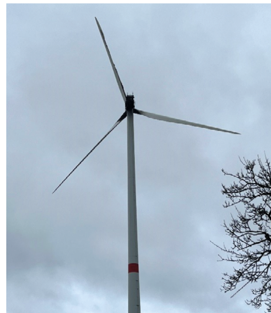
Abbildung 15: Windrad mit ausgebrannter Gondel und beschädigten Rotorblättern
