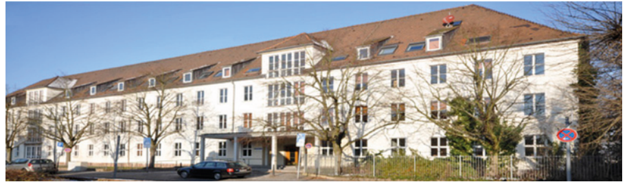
Abbildung 1: Dienstgebäude LUA in St. Arnual
