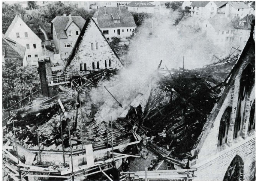
Bild 7. Kirchenbrand. Die Gewölbedecke verhinderte eine Ausdehnung des Brandes in das Kirchenschiff. Brand- und starke Rauchschäden beliefen sich auf etwa 1,5 Mio. DM. (Bildaufnahme: Westfälische Feuersozietät, Münster.)
