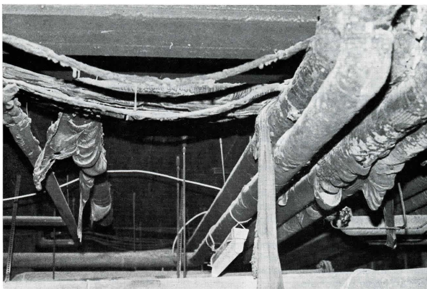
Bild 5. Zerstörte Elektroleitungen und PVC-ummantelte Rohrisolierungen.
