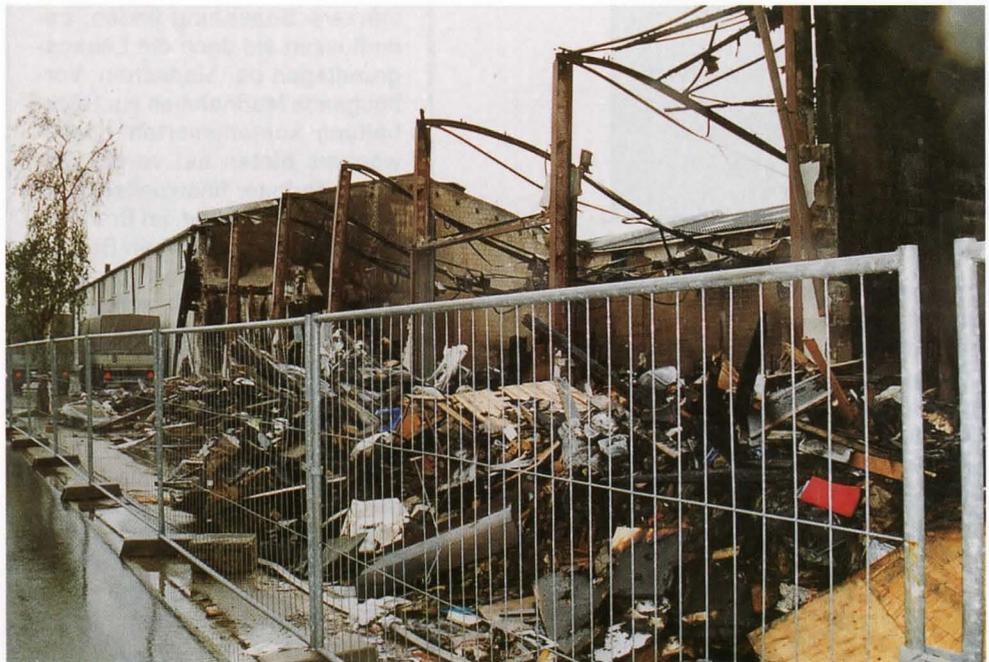
Brandschaden in einem Möbellager einer Spedition. Durch einen Bauzaun wurden die Brandstellenabfälle bis zur Sortierung und zum Abtransport gesichert.
