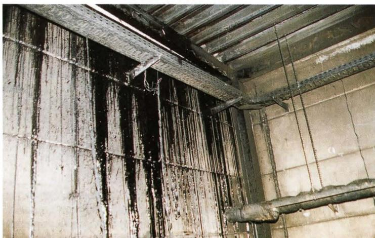
Bitumenablaufspuren auf Porenbeton-Wandplatten können im Sandstrahlverfahren entfernt werden. Während der Porenbeton danach wiederverwertet werden kann, müssen verunreinigte Strahlmittelrückstände entsorgt werden.
