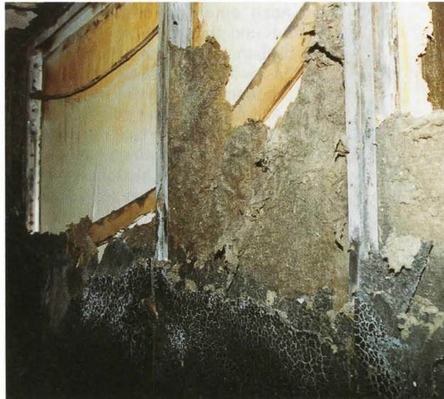
Dämmplatten aus Mineralwolle in einer zerstörten Leichtbauwand müssen getrennt entsorgt werden.
