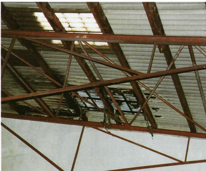
Thermisch beschädigte Wellasbestzementplatten. Für die Sanierung und Entsorgung ist die TRGS 519 zu berücksichtigen.
