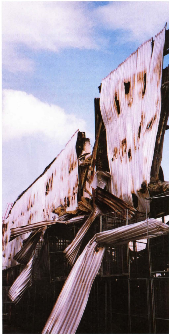
Bild 3: Die Reste der Westfassade. Auch hier wird deutlich, daß trotz des nichtbrennbaren Baumaterials schon bald akute Einsturzgefahr bestand.
