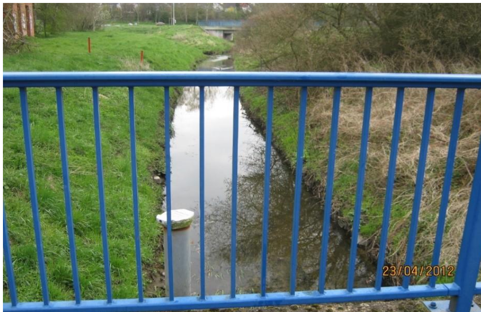
Abbildung 4-2 Kronshagen-Ottendorfer Au, definiertes Profil, daher geeignet für eine Abflussmessung (2021, A. Maaß, UWB Kiel)
