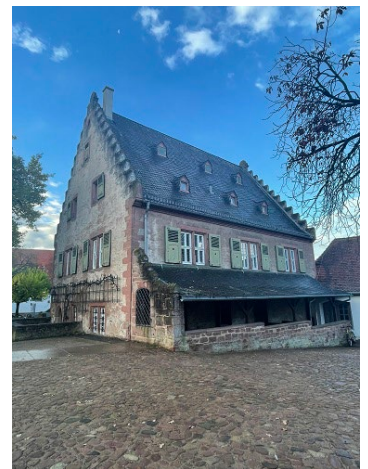
Die Mühle des Klosters Seligenstadt ist zu Vorführzwecken noch im Betrieb. ©SG, Foto: Susanne Király
