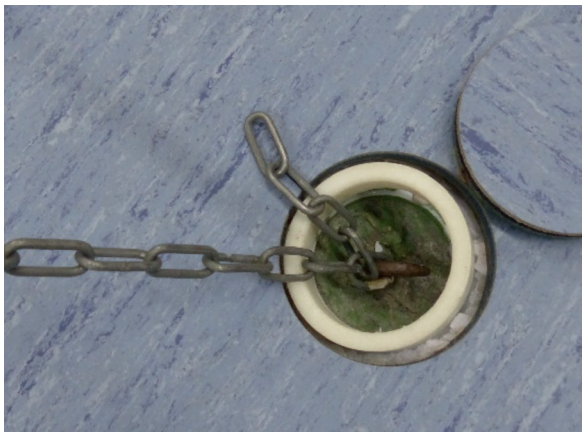
Abb. 40: Fest eingehängte Kette beim Spannbarren
