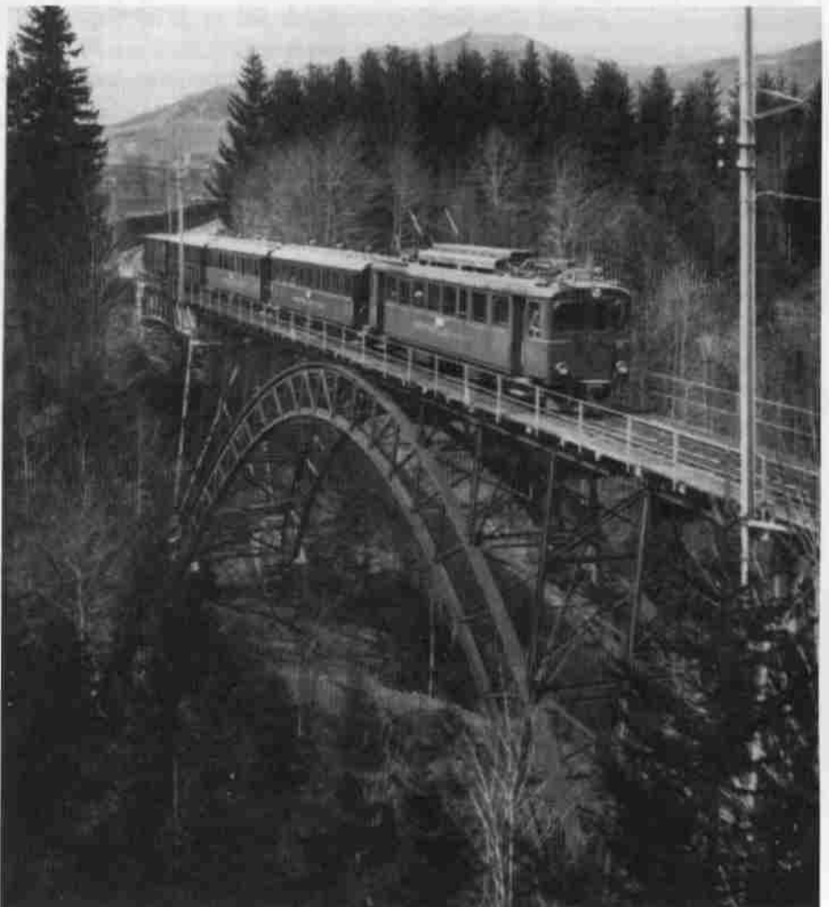
Die Kaubachbrücke ist die bedeutendste Kunstbaute der Appenzeller Bahn; die alte stammte aus dem Jahre 1886.
