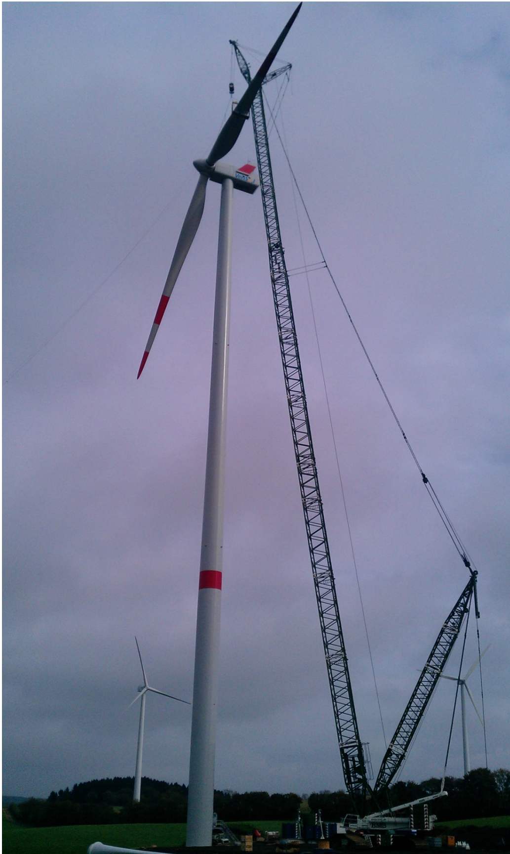
Abb. 8 „Hochzeit“ – Zusammenführung von Rotorblattstern und Maschinenhaus
