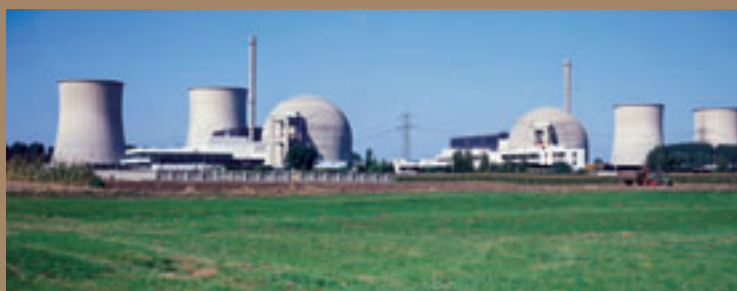
Einbau von Wasserstofffiltern im KKW Biblis
